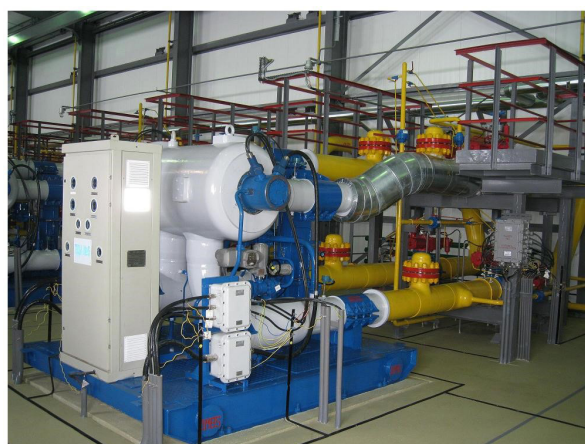
Рис. 1. ТДА АО «Турбохолд» на станции охлаждения газа ГП-16 на Песцовой площади. Турбодетандерный агрегат с горизонтальным валом. Газодинамические проекты ЛГДТМ СПбПУ
