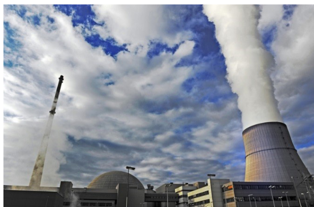
Рис. 2. Вертикальная теплая воздушная струя из градирни АЭС, действующая по схеме аэротермического кулера при отсутствии приземного ветра
