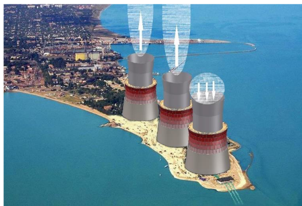
Рис. 5. Блоки аэротермического кулера с различным количеством инжекторов:
