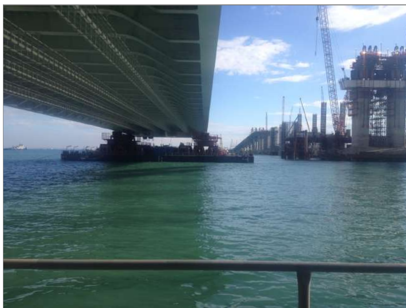
Рис. 12. Позиционирование и заведение плавучей системы с автодорожным пролетным арочным строением в створ моста с помощью системы позиционирования (11 октября 2017 г., фото АО «ЦКБ «Коралл»»)
