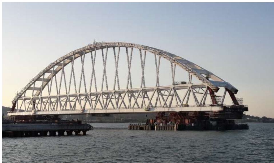
Рис. 11. Плавучая система на оси подходного канала 27 августа 2017 г. (фото АО «ЦКБ «Коралл»»)
